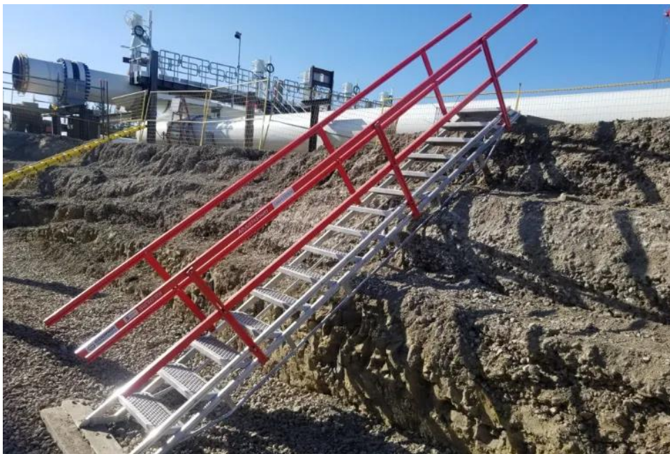
Рисунок 16 – Передвижная металлическая лестница для спуска в котлован - складные лестницы (изготавливаются из диэлектрического композита) (рисунок 17);
