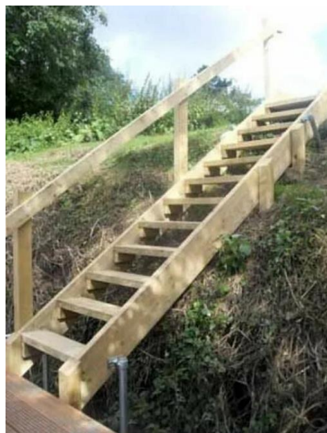
Рисунок 15 – Деревянная лестница для спуска в котлован
