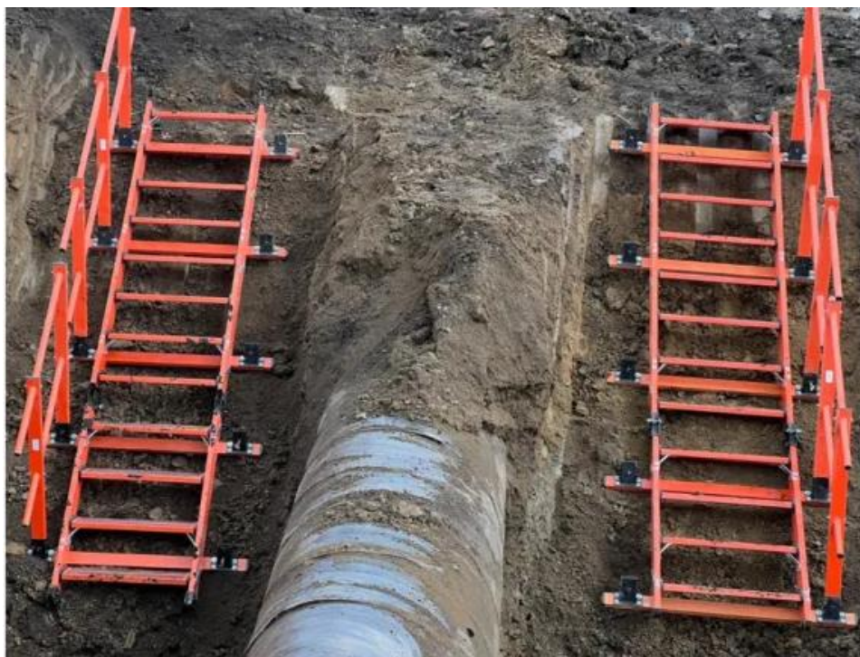
Рисунок 17 – Складная лестница для спуска в котлован - вертикальные лестницы со стационарными креплениями.
